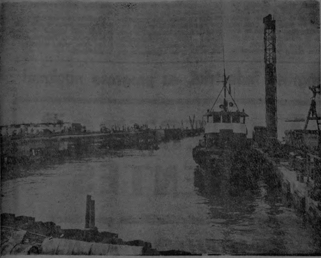
Este es el muelle 70 el cual está casi terminado y que fue construido en Puerto Limón. Este mismo mes entrará en operación. Tiene capacidad para que atraquen tres barcos al mismo tiempo de 10 mil toneladas cada uno.
